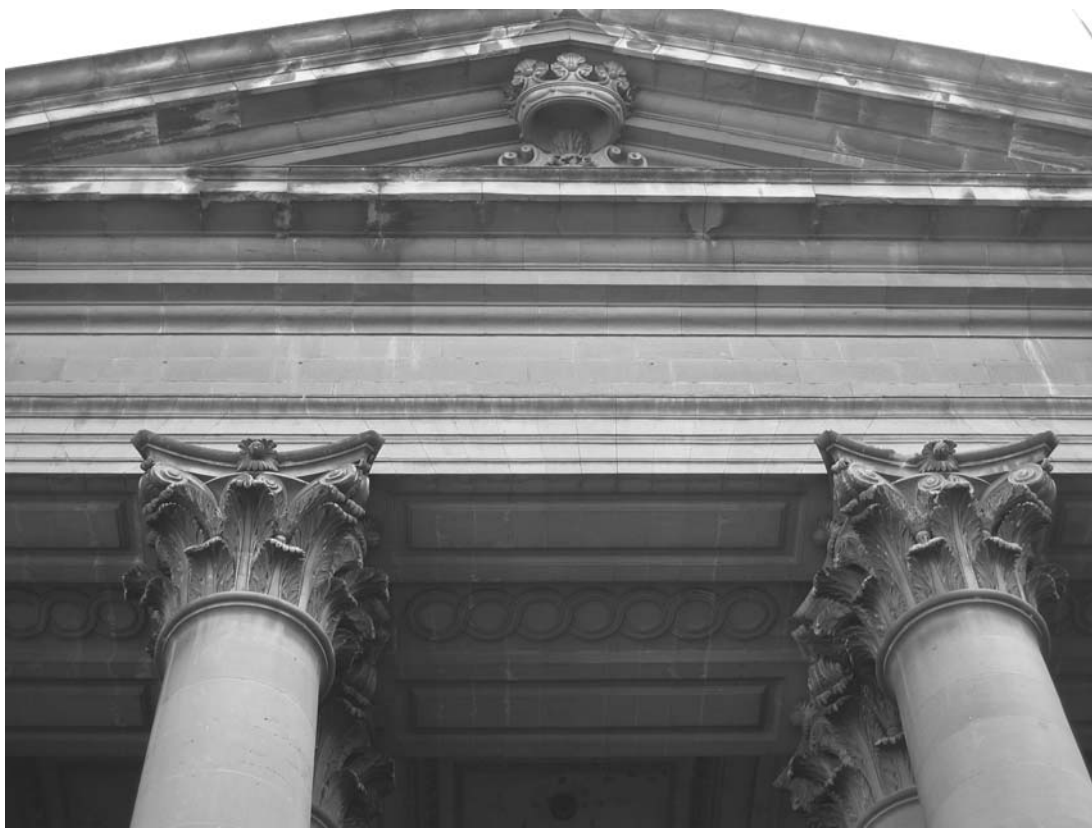
7. Ventura Rodríguez, Fachada de la Catedral de Pamplona, detalle del pórtico.
