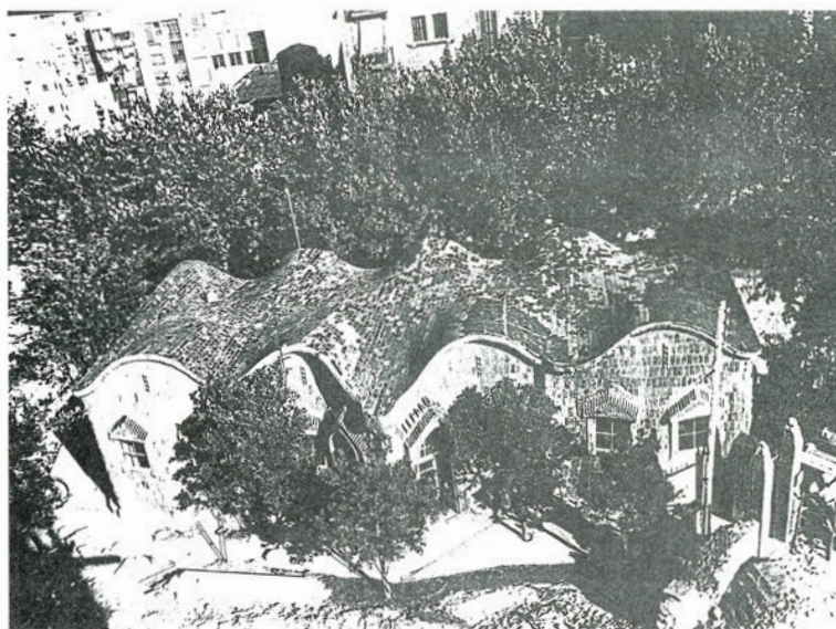
Fig. 2. Fachada principal y cubierta de las escuelas. (Foto Aleu, 1970).
