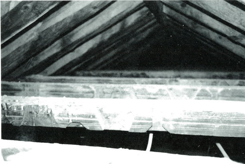
1.- Una de las fotos realizadas en mi primera visita al espacio bajo la cubierta de la iglesia de San Pedro. Se aprecia claramente el agramilado de los pares y los rebajes para encaje de los taujeles que forman la lacería.
