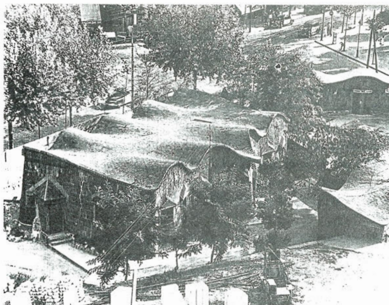
Fig. 1. El edificio de las Escuelas desde la obra en construcción de la fachada de Poniente de la Sagrada Familia. (Foto Aleu, 1958).
