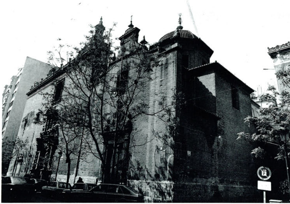
Lám. 1. Vista general de la antigua iglesia de San Andrés, actual parroquial de San Juan de la Cruz de Valencia.
