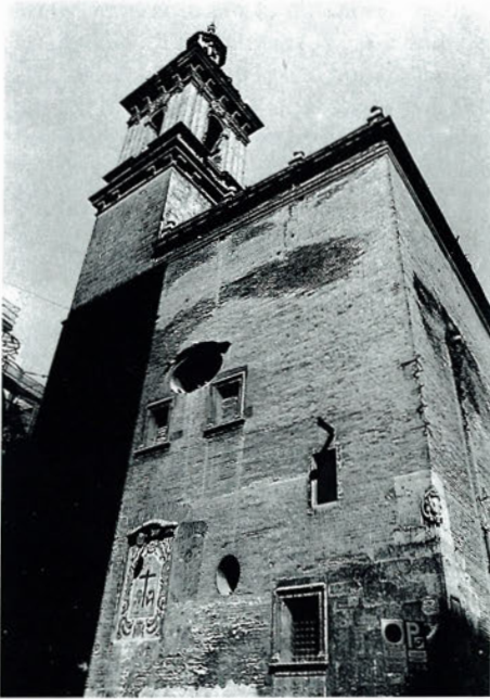
Lám. 4. Fachada lateral, recayente a la calle de Villarragut.
