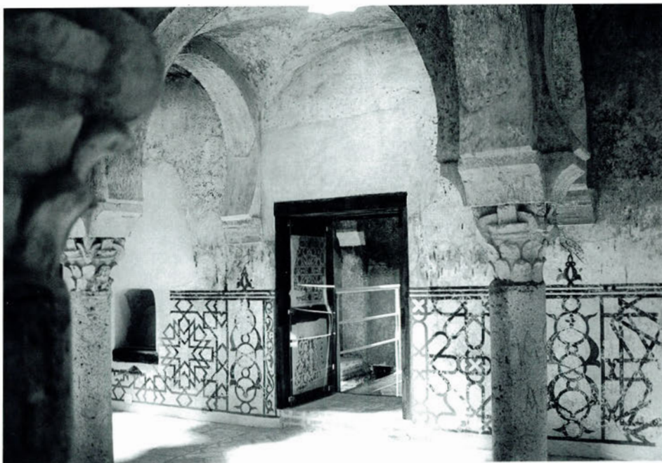
2.-Aspecto general de zócalo “de lo morisco”
