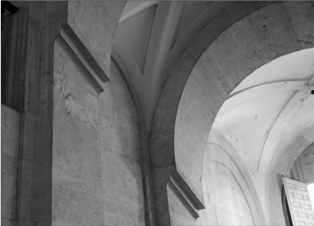
21. Detalle del arco abocinado de la escalera de la Real Academia.
