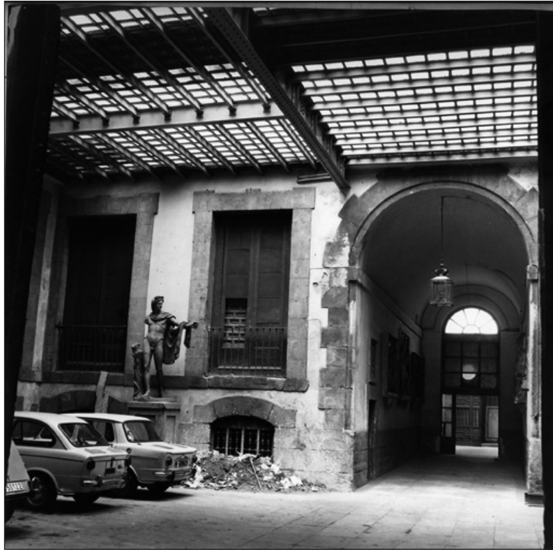
10. Estado del patio principal anterior a la reforma de Chueca Goitia. Archivo fotográfico de la RABASE.
