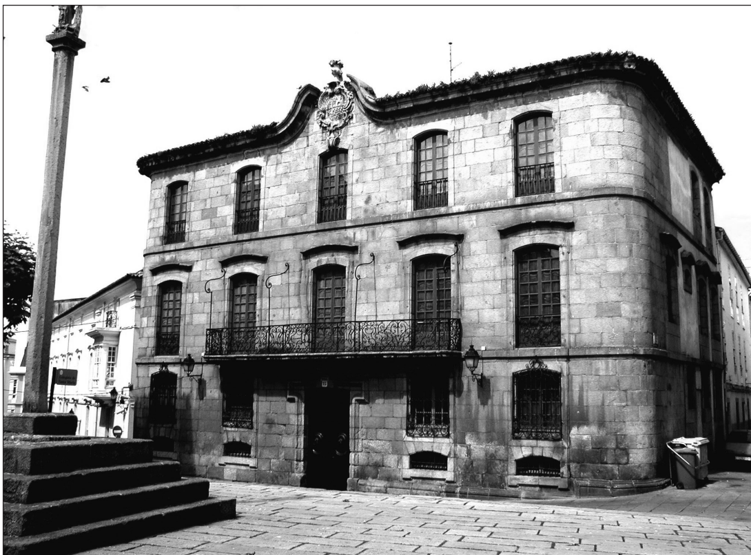
13. Casa Cornide en la ciudad vieja de A Coruña.
