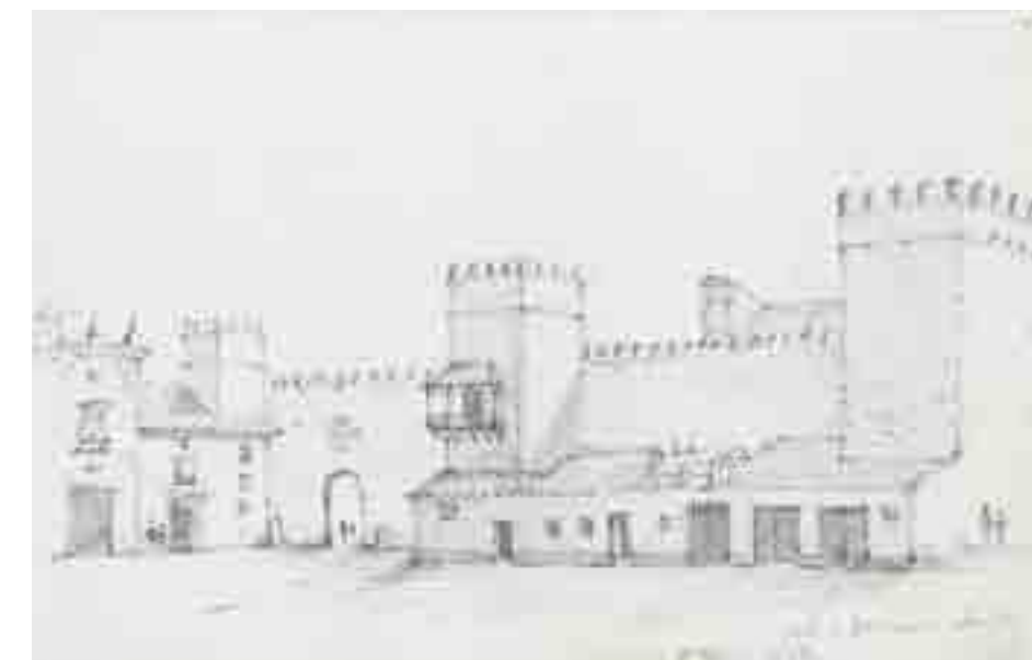
[Il. 34] Sevilla. Murallas del Alcázar y puerta del Patio de Banderas
