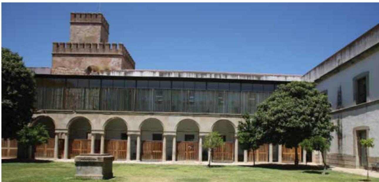
Fig. 5.- Fachada sur del ala norte del patio principal mostrando la sustitución de la solución original de fábrica de todo el piso alto del patio por una celosía de madera. (Foto A. Almagro).
