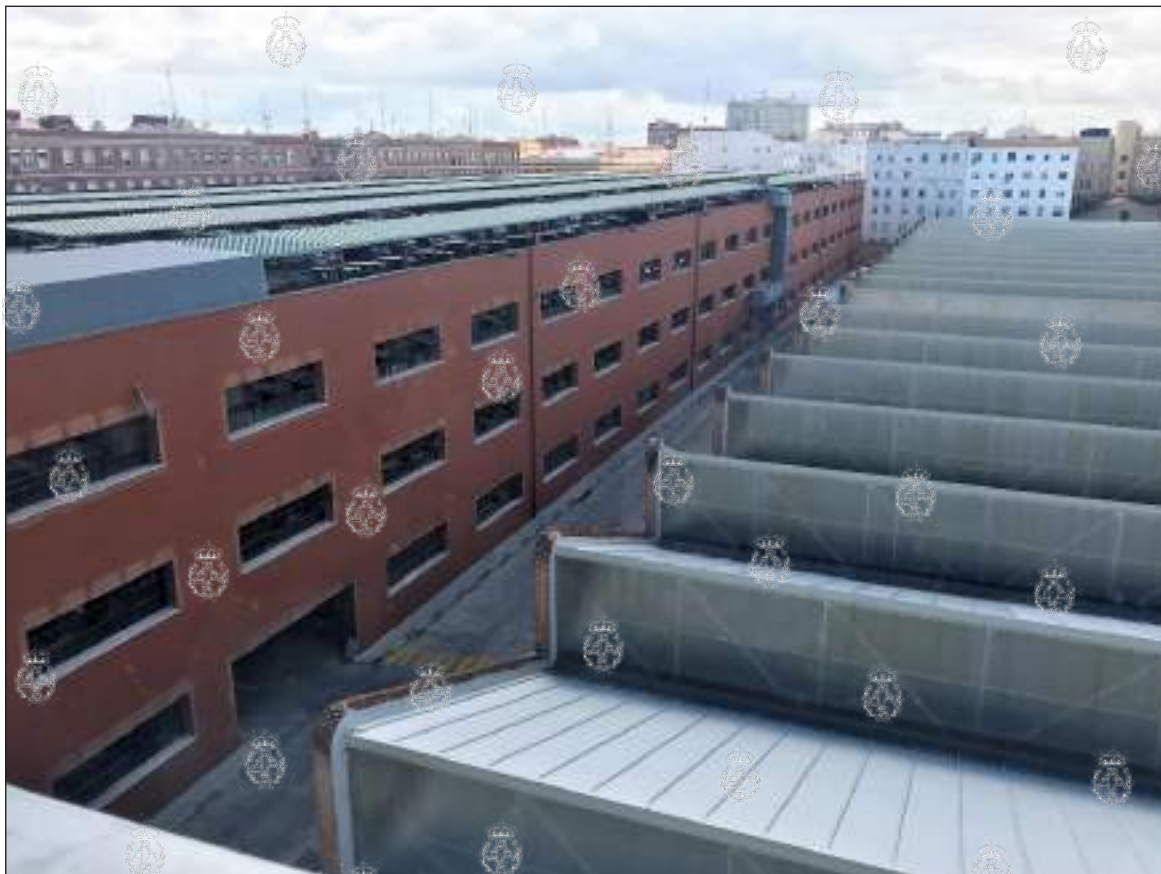
Vista parcial de los Talleres (dcha.) y del Garaje (izda.), sobre cuya terraza, en otro tiempo para pruebas y exposición de vehículos, aparecen largas marquesinas ocupando toda la superficie. Foto P. Navascués (4 abril 2018).
