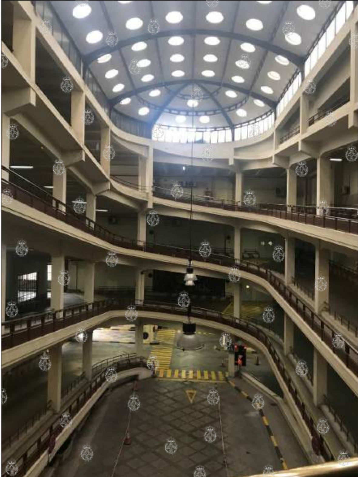
Vista actual de la rampa del PME, protegida según la reconsideración final del Departamento de Ordenación Urbanística I, del Área de Gobierno de Urbanismo y Vivienda del Ayuntamiento de Madrid, en su sesión de 27/07/2014, según consta en Acta 27/2014. Foto P. Navascués (4 de abril de 2018).
