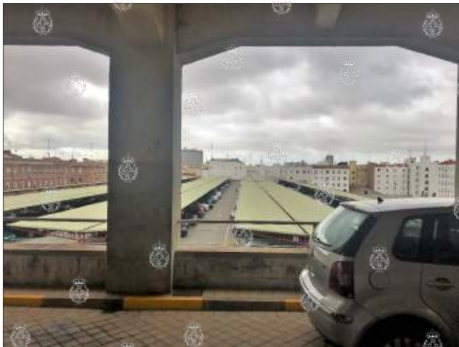
Vista de la terraza del garaje, hoy ocupada por marquesinas de aparcamiento, que en su día fue espacio para pruebas y exposición de vehículos. Foto P. Navascués (4 de abril de 2018).
