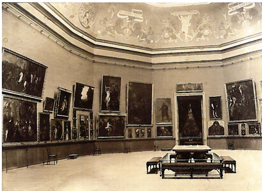
FIG. 7. Fotografía de 1893-1899 de la Sala de Isabel II en el Museo del Prado con la mesa de Don Rodrigo Calderón en primer término y al fondo el Tablero de Felipe II colocado en la Galería Central.
