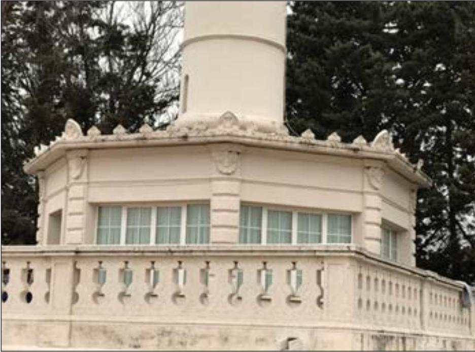
Aspecto actual del cuerpo bajo de observación, al nivel de la terraza de la Torre de Señales, en la que se ha rebajado la altura original de los dinteles de los huecos.
