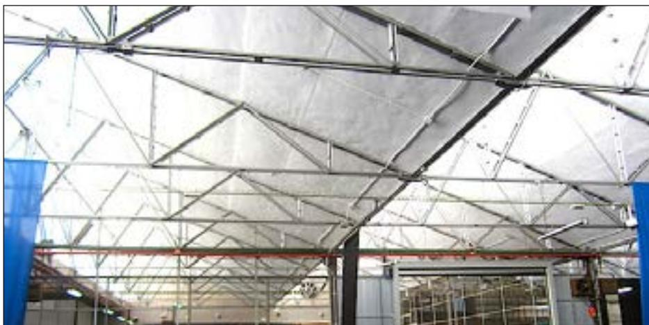
Detalle de las cerchas metálicas de la cubierta del taller. Cortesía del Parque Móvil del Estado, O.A.
