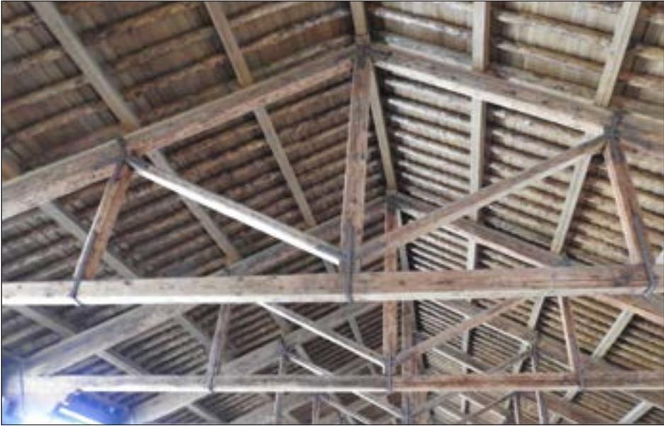
Detalle de la cubierta de cuchillos triangulados.
